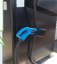
完了後、車からコネクタを外し充電器に戻せばOK
